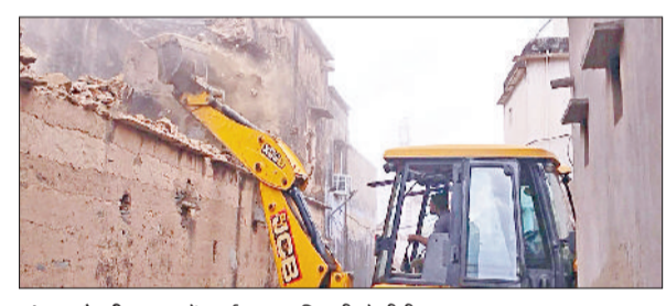
नांगल चौधरी। शहर में जर्जर भवन गिराती जेसीबी। फोटो: हरिभूमि
